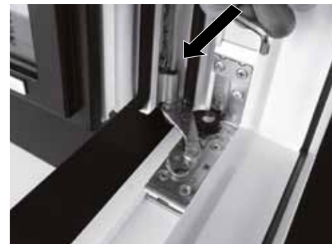
Höhenverstellung Inbus M4
