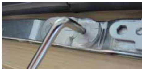
Seitenverstellung oben Torx 15
