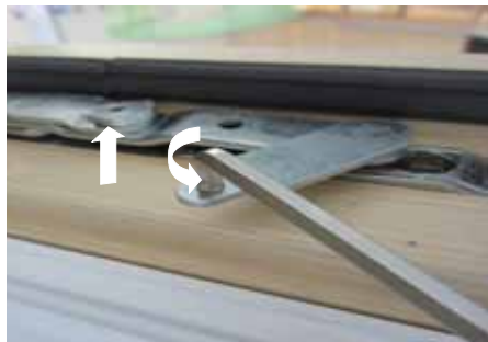
Aushängen oben bei Schere
